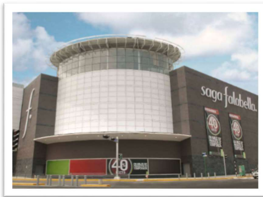
Centro comercial Open Plaza Surquillo
